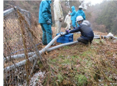
写真9：被災ため池に石川県土連による簡易排水施設(サイフォン)の設置
