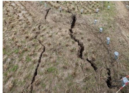
写真2: 農地の亀裂(石川県輪島市)
